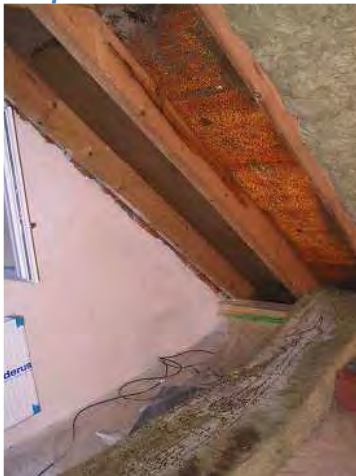
Photo 11 : Mauvaise migration de la vapeur d'eau entraînant le développement de parasites, WIGWAM Conseil
