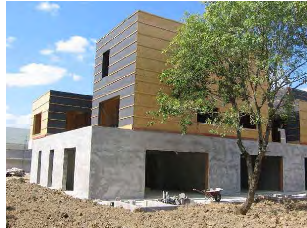
Photo 31 : Chantier de l'opération Cap Vert – MOA : SILENE (44)
