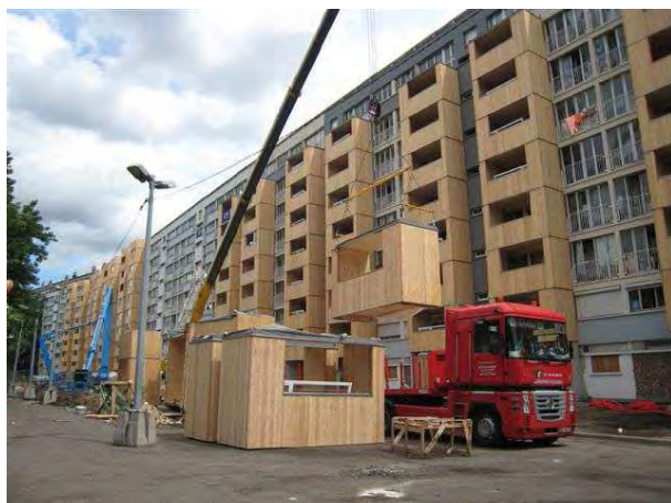
Figure 15 : Mise en œuvre procédé modulo bois développé par ARBONIS Construction Lyon
