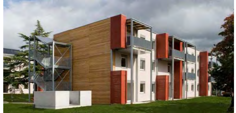
Photo 37 : Coursive extérieur métallique Résidence du Cèdre, MOA : Obernai Habitat
