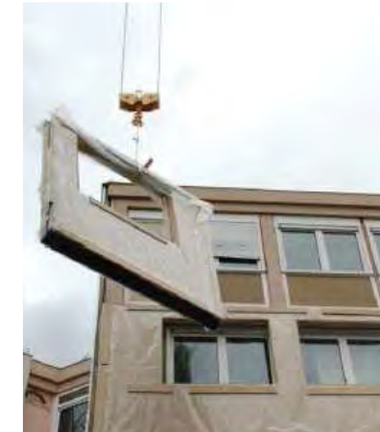
Photo 15 : Rénovation de 570 logements en ossature bois, en site occupé, MOA : SMI OSICA
