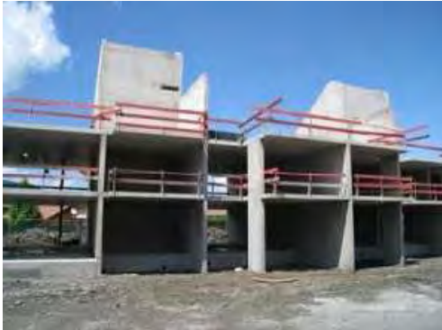
Photo 33 : Opération Les Cheylas - Ossature béton armé – MOA : OPAC 38 (38)
