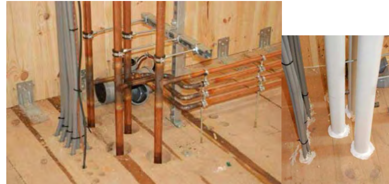
Photo 16 : Réservation sur panneau massif KLH, Les Heliades MOA : Le Toit Vosgien
