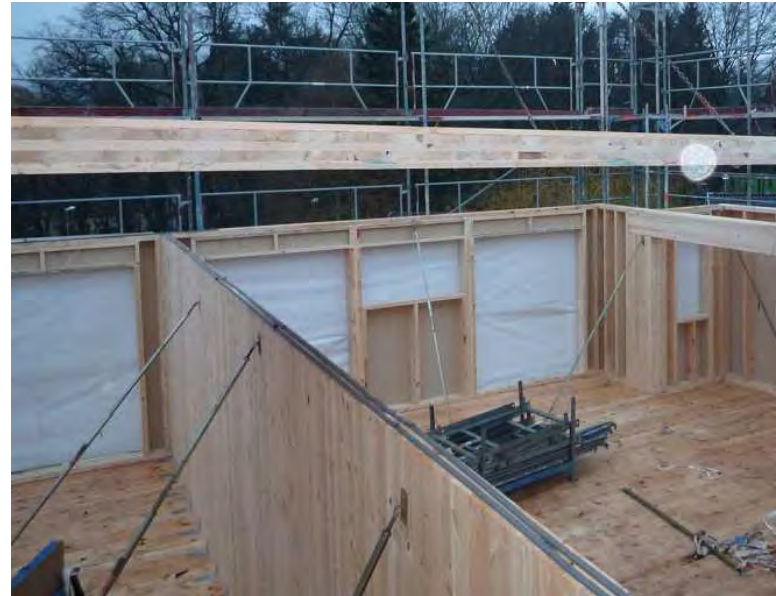
Photo 29 : Refend panneau bois massif KLH, MOA : SA Le Toit Vosgien (88)
