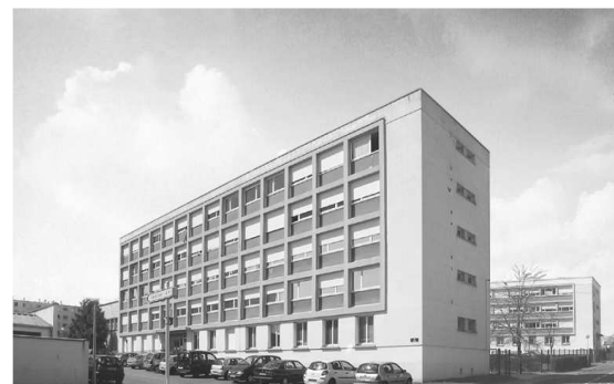
Figure 12 : Bâti existant Avant le projet "ECORCE" sur Monchat Lyon
