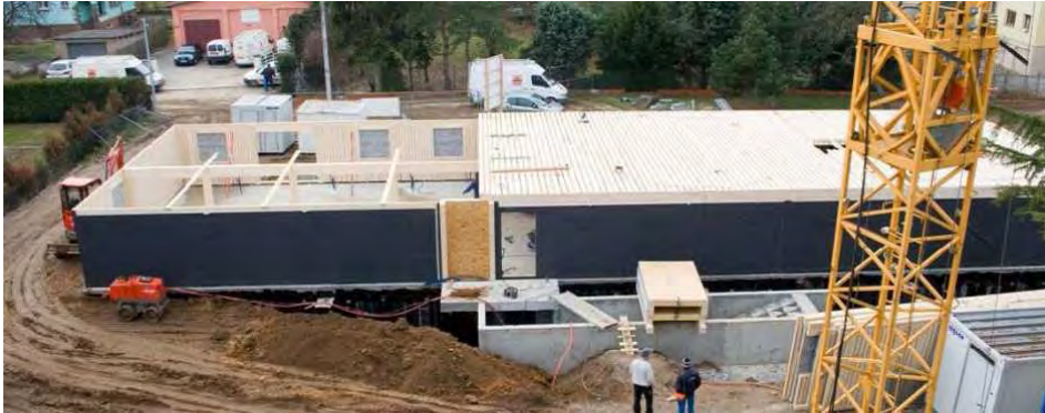
Photo 26 : Sous Bassement béton et premier niveau uniquement en panneau massif, MOA : Obernai Habitat (67)
