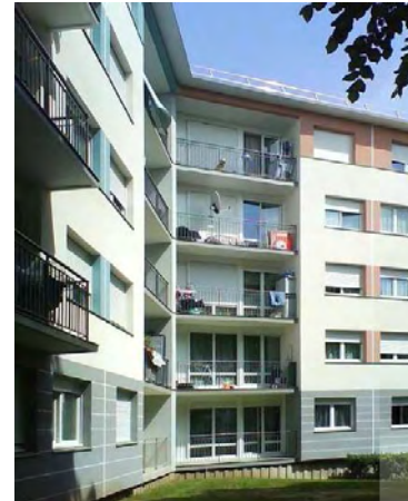
Photo 25 : Après la réhabilitation 570 logements - Ville de Gonesse
