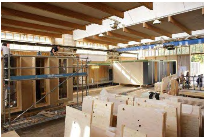
Photo 17 : Ligne de production ossature et modules tridimensionnels KODUMAJA
