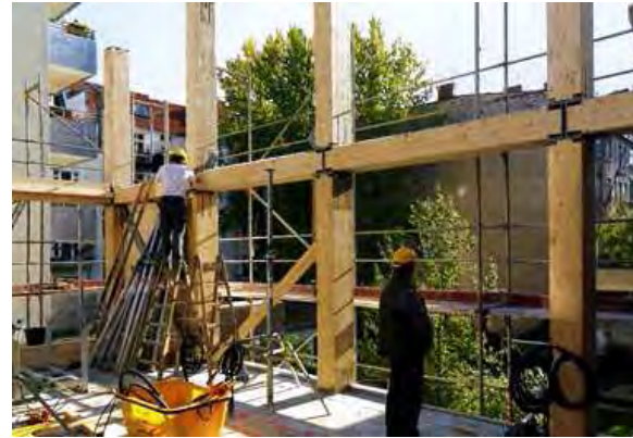
Photo 6 : Structure poteau poutre Stadhaus – Londres
