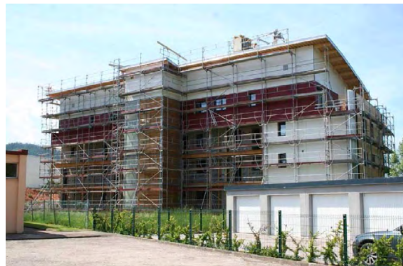
Photo 35 : Cage d'ascenseur béton sur un projet bois R+4+ attique, MOA : SA Le Toit Vosgien (88)
