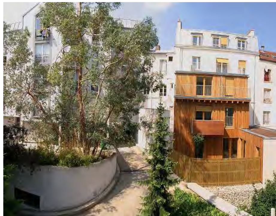
Photo 14 : Extension, construction, logement social Paris, MOA : SIEMP (75)
