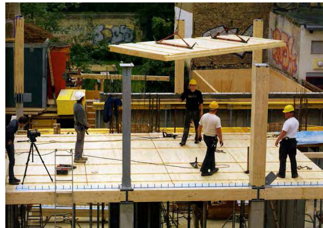
Photo 7 : Structure poteau poutre Stadhaus - Londres
