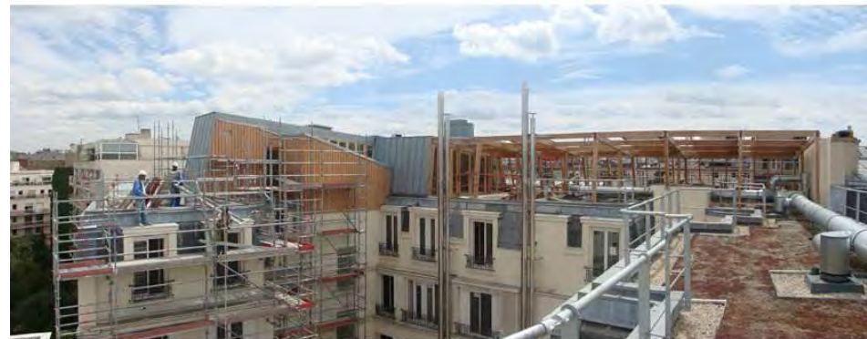
Photo 13 : Surélévation d'un logement social SIEMP (75)
