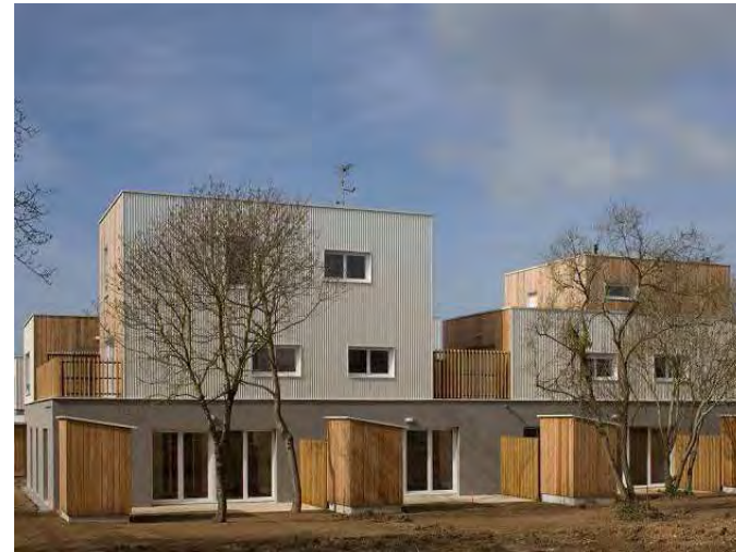
Photo 32 : Livraison de l'opération Cap Vert – MOA : SILENE (44)
