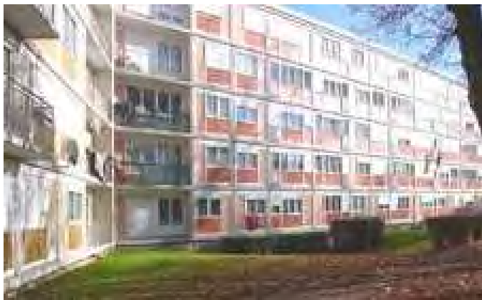
Photo 24 : Avant la réhabilitation 570 logements - Ville de Gonesse
